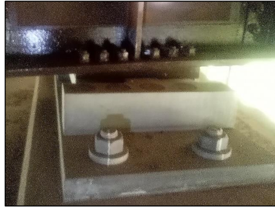
長寿命化が必要な箇所となる支承部材
