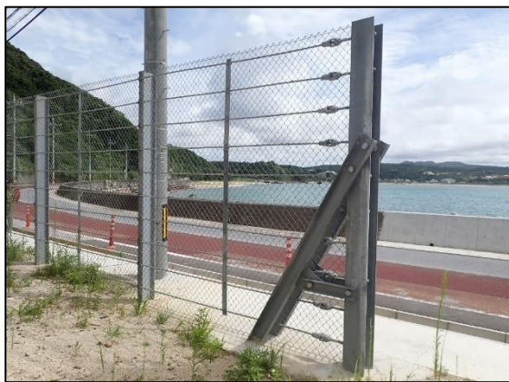
沿岸部の落石防止製品(支柱)に採用されたタナカーAZ
