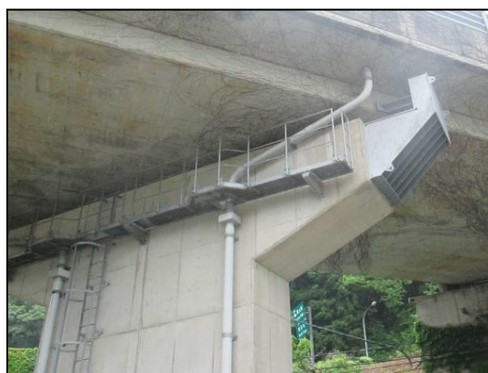
海岸沿いの高架道路橋検査路・落橋防止装置
