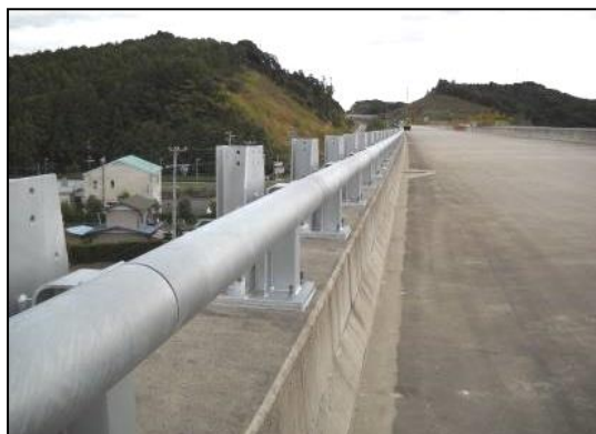
凍結防止剤散布個所の鋼製高欄
